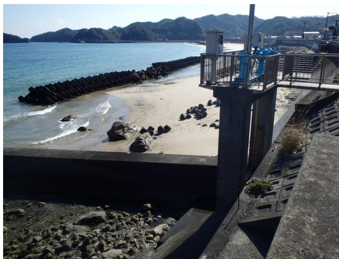
樋門・離岸堤（穴喰浦）
