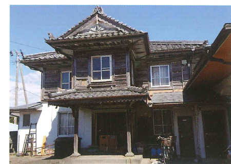
多田家住宅洋館
