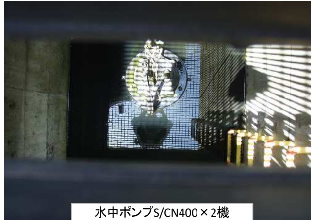
外付け小型水中ポンプ配管
