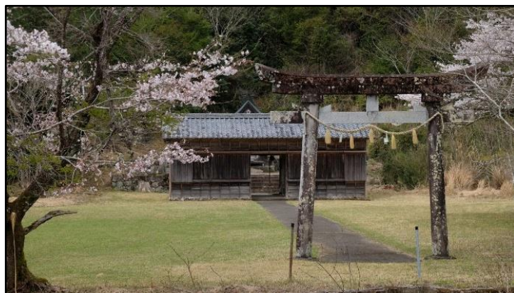
割拝殿（鳥居の奥の建物）
