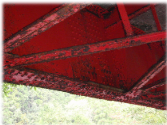
写真1. 鋼材の腐食
