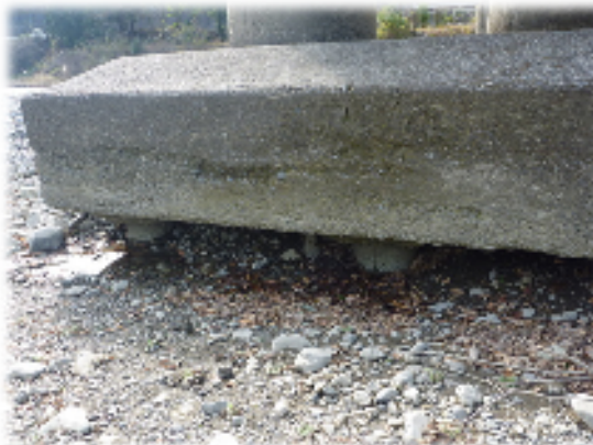
写真5. 橋脚下面の洗掘
