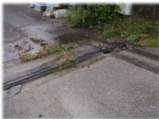
写真6. 路面の段差
