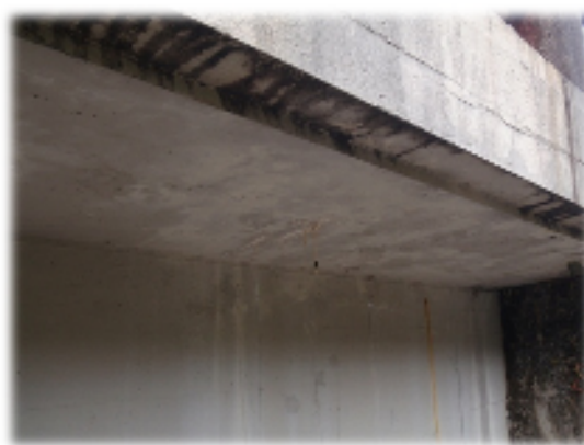
写真2. コンクリート桁のひび割れ・遊離石灰
