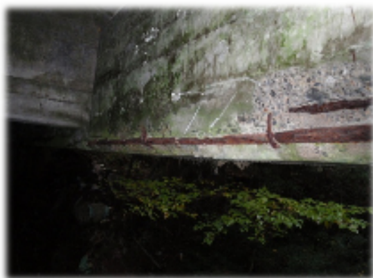
写真3. コンクリート桁の剥離・鉄筋露出
