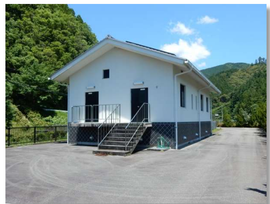
神野農業集落排水機場
