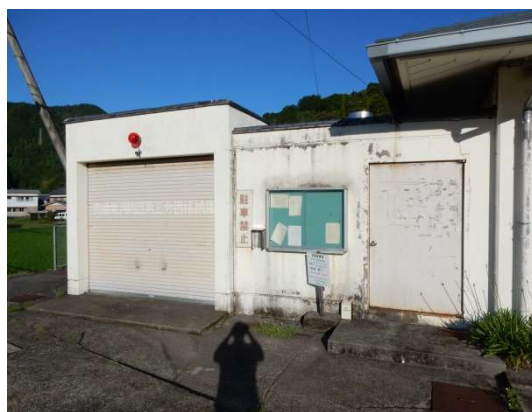
穴喰第3分団消防屯所
