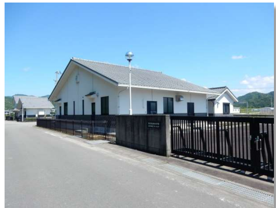
川西農業集落排水機場
