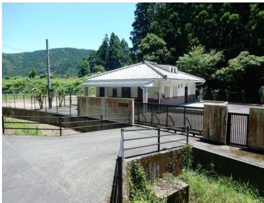
大井農業集落排水機場
