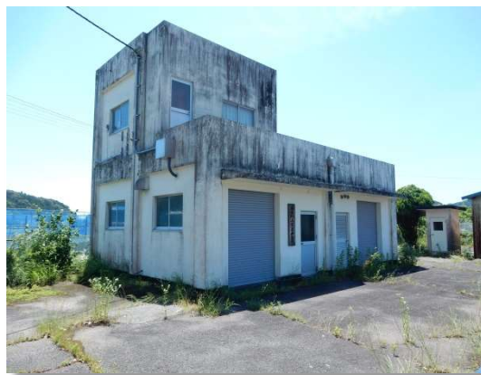
水源地ポンプ室
