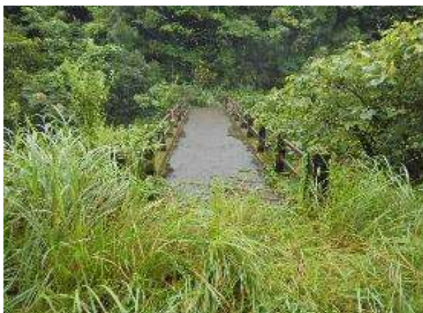
写真6-1 集約・撤去検討橋梁
