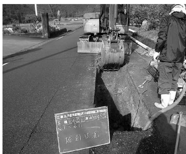
穴喰公共下水道工事
