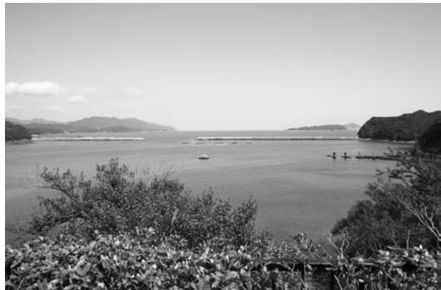
完成した浅川マリンタウンプロジェクト（津波防波堤）
