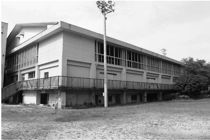
町民体育館として耐震補強される（旧海部中学校体育館）
