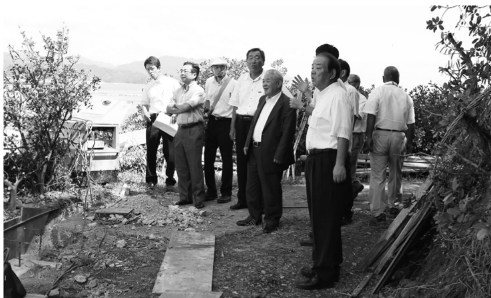
台風12号被災現場巡視 浅川湾遊歩道
