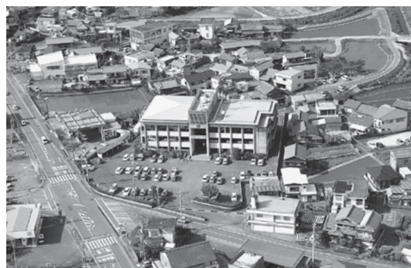
海陽町役場海南庁舎
