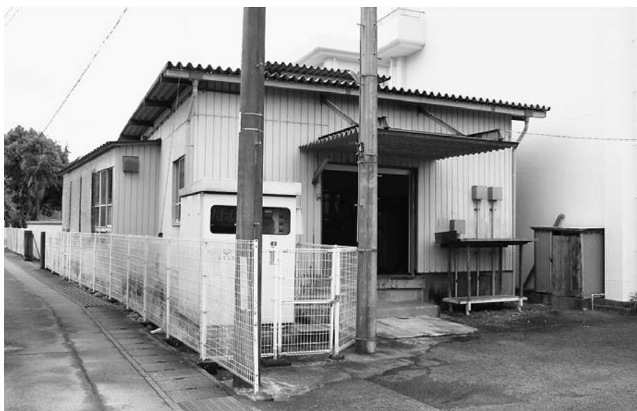
雨漏り改修 海南給食センター
