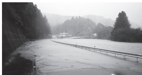
台風12号で冠水した国道193号相川笹草
