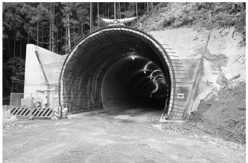
工事中の伊勢田トンネル
