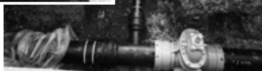
水道配水管工事
