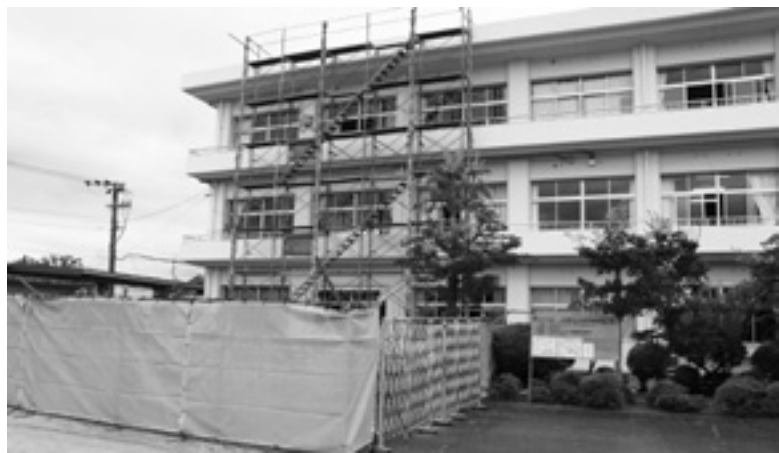
津波避難階段の工事が進む海陽中学校
