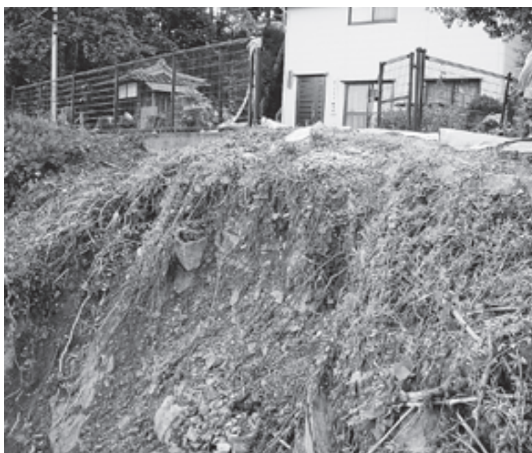
观音庵の崩壊箇所
