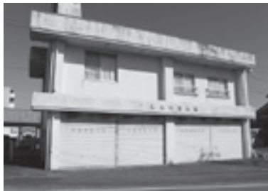
海南庁舎前消防屯所
