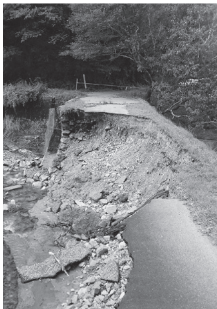
崩壊した町道 神祇線
