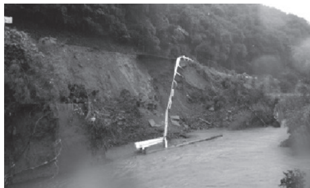
④崩壊し今も通行止めの町道浅川大山線
