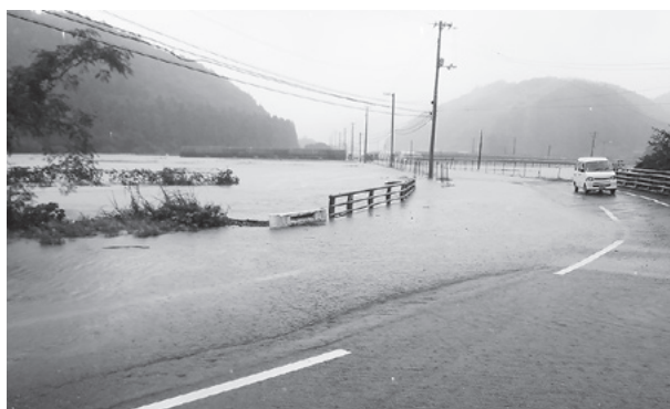
⑨冠水した県道 301 号尖喰尾崎
