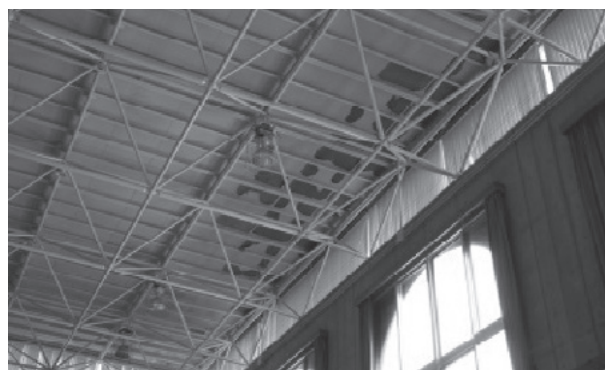
⑩破損した野江町民体育館
