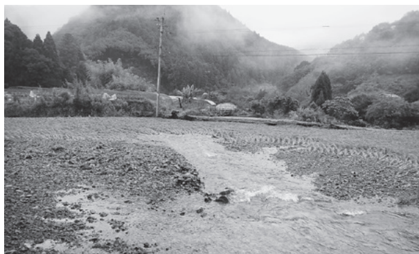
③水田に氾濫した若松川
