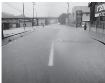
国道55号通行止め (四方原)
