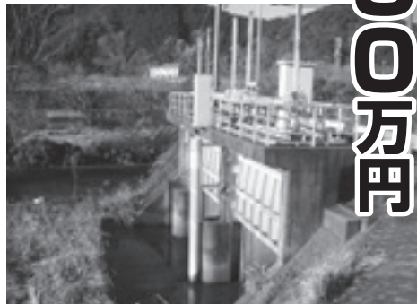
松本排水機場
