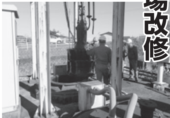
ポンプの修理
