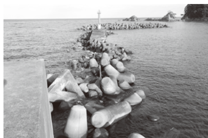
奥馬漁港の改修箇所
