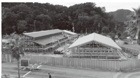
建築中の「まぜのおか管理棟・交流棟」
