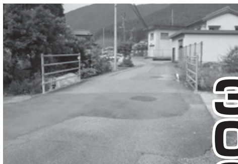
補修される町道
