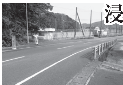
排水路改良箇所
