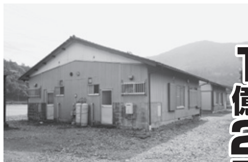
改修される旧教員住宅
