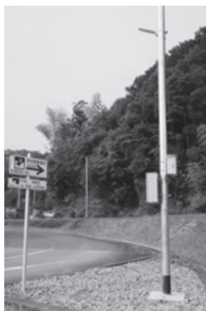
避難路看板の誘導灯
