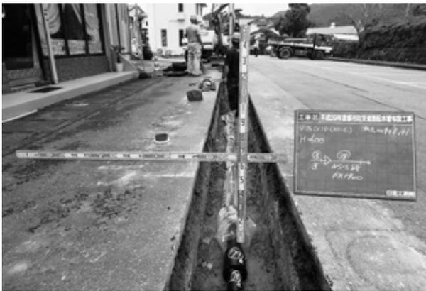
耐震管に交換される水道工事
