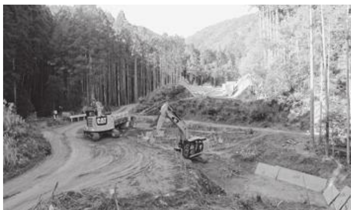
工事が進む芥附海部線
