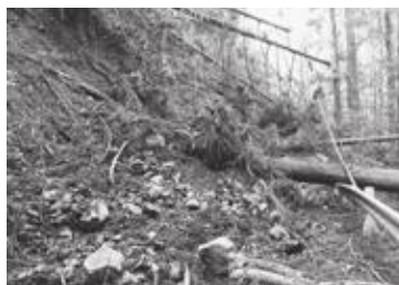
第2工区(延長 33m)
