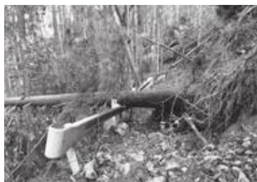
第1工区(延長 50m)
