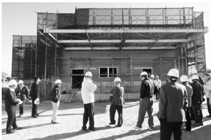
巡視：建設中の給食センター
