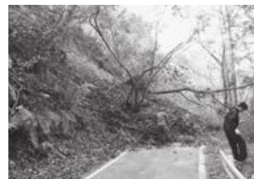
第3工区(延長 11m)
