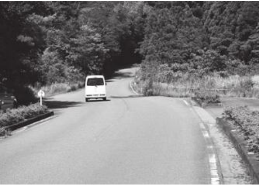
四方原五反田線の未改修箇所
