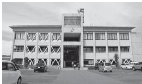
海陽町役場 海南庁舎
