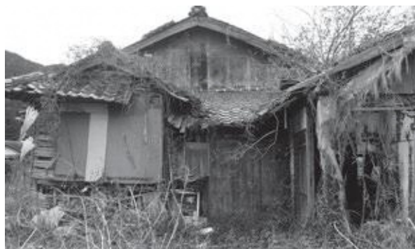
解体前の老朽住宅
