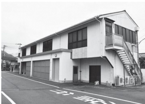
推進協議会が設置される突喰庁舎別館
