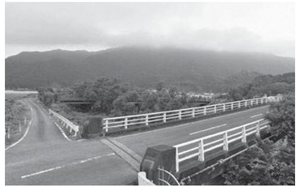
補修する中角大橋（手前）と撤去する中角橋（奥）
