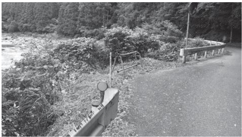
県道の危険箇所
