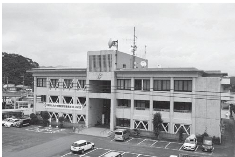
海陽町役場 海南庁舎
