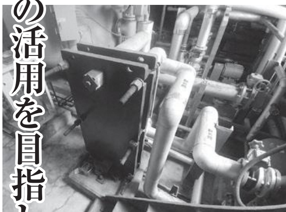
老朽化している温水プール熱交換器
