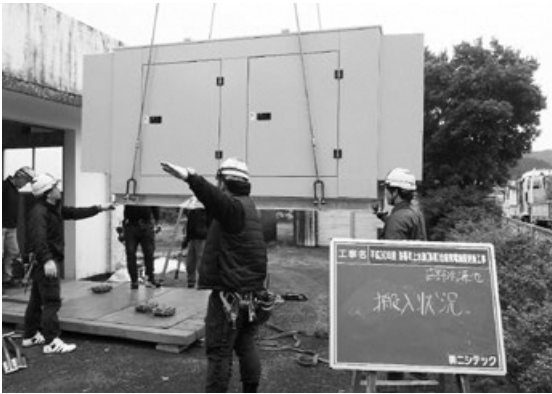
老朽化した発電機取替状況 (吉野水源地)
