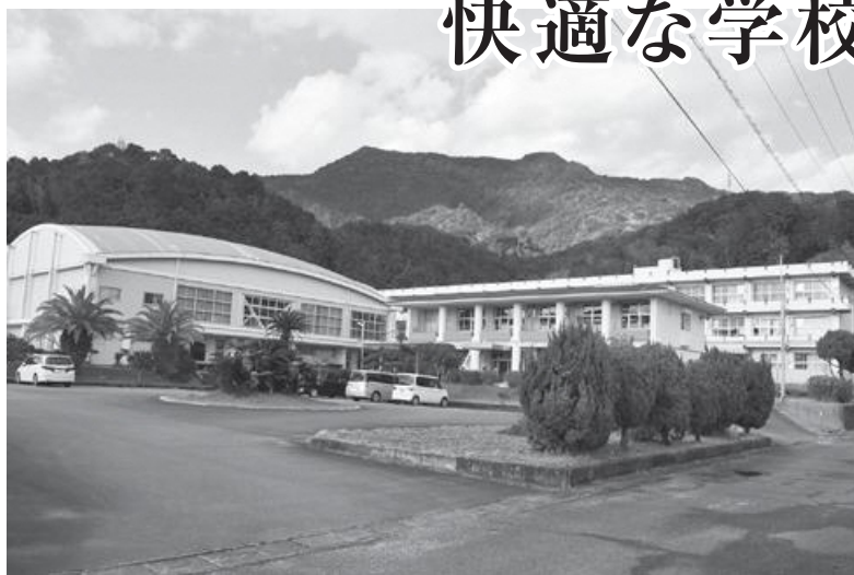
トイレ改修する宍喰中学校
