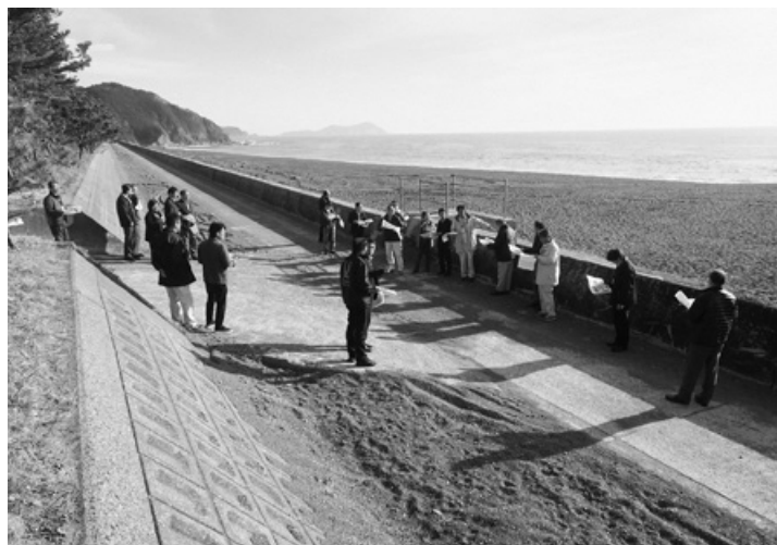
大里松原海岸の巡視
