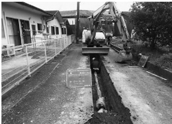
耐震水道管への交換工事 (大里字白水)
