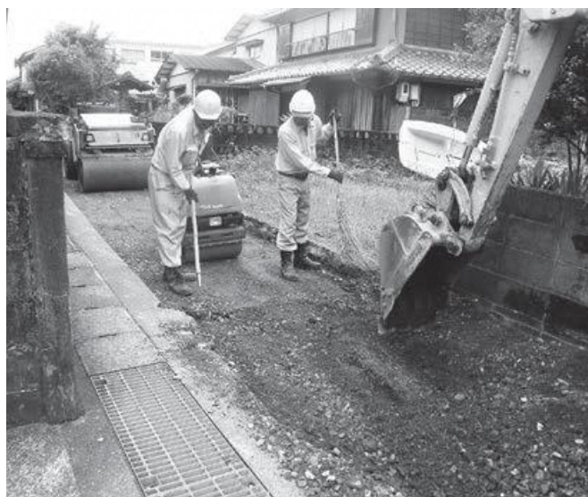
町道の舗装修繕工事
