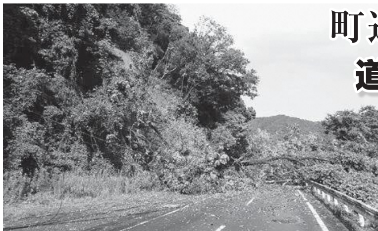
崩れた土砂と倒木にふさがれた北岸線
