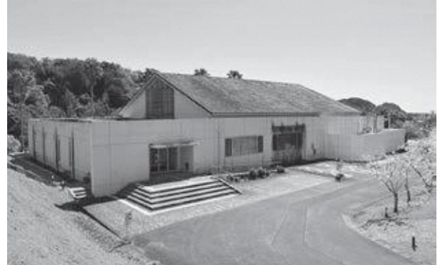
屋根等が改修されるB & G海洋センター
