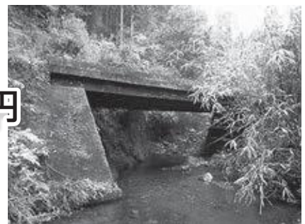
架け替えられる穴瀬谷4号橋の全景
