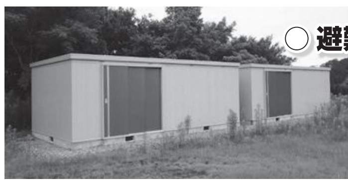
現在、蛇王運動公園野球場横広場に設置している防災倉庫
