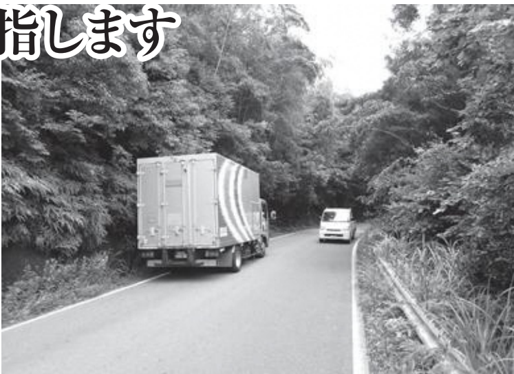
大型車も通行し、危険な未改良区間
