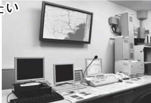
防災行政無線の放送室（海南庁舎）
