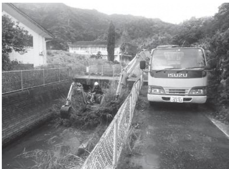
河川内の土砂除去作業 (突喰の久保川)
