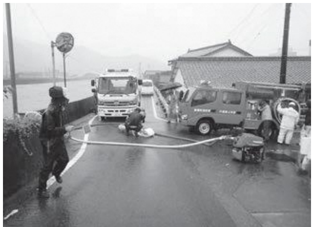
消防団に加え、県の排水ポンプ車も 応援配備された突喰川への排水作業
