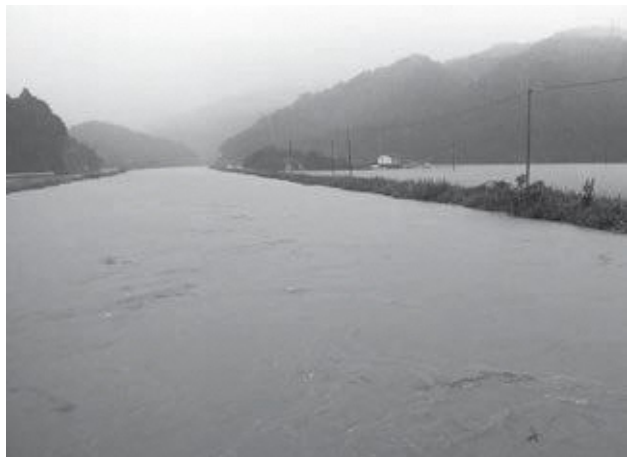
母川と堤防内側の水位がほぼ同じになり住宅が浸水 (中山居敷地区)
