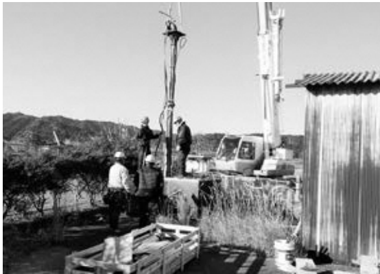
吉野水源地 No.3 水中ポンプ更新工事
