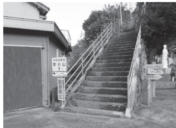
排水工事がされる避難階段
