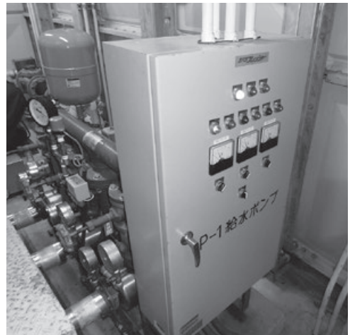
ポンプと操作盤
