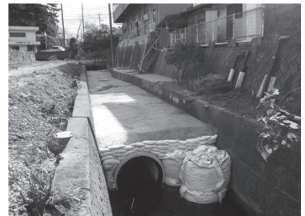
仮復旧工事後の状況
