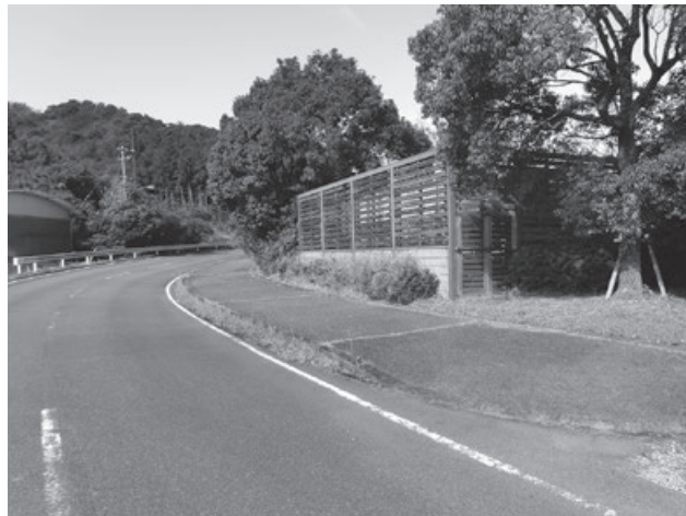
ポンプ施設外観
