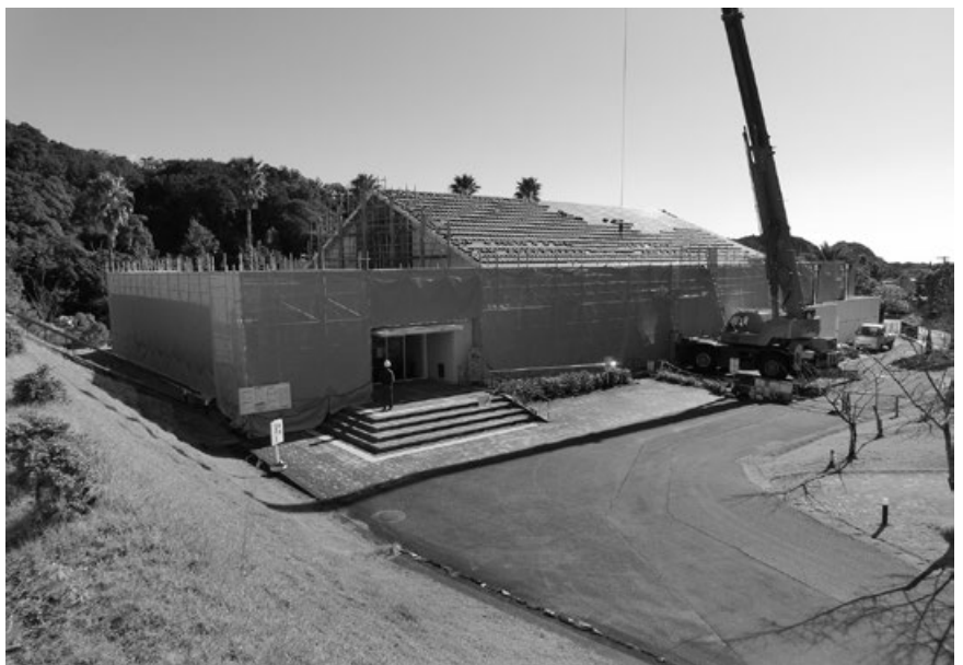
改修工事中のB & G海洋センター
