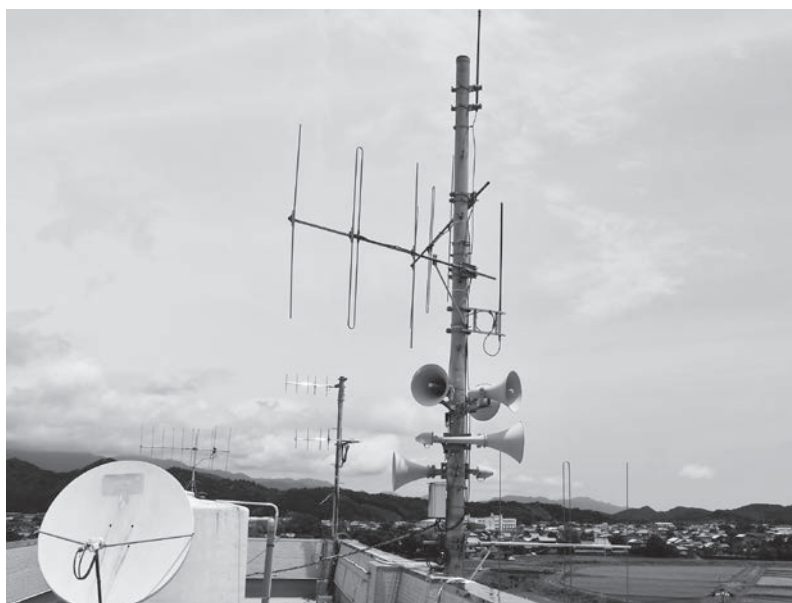
海南庁舎屋上に設置されている防災行政無線のアンテナ
