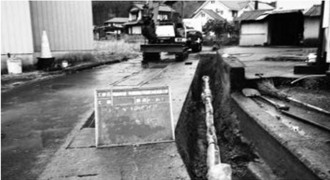
町道板取線の配水管本設工事の施工状況
