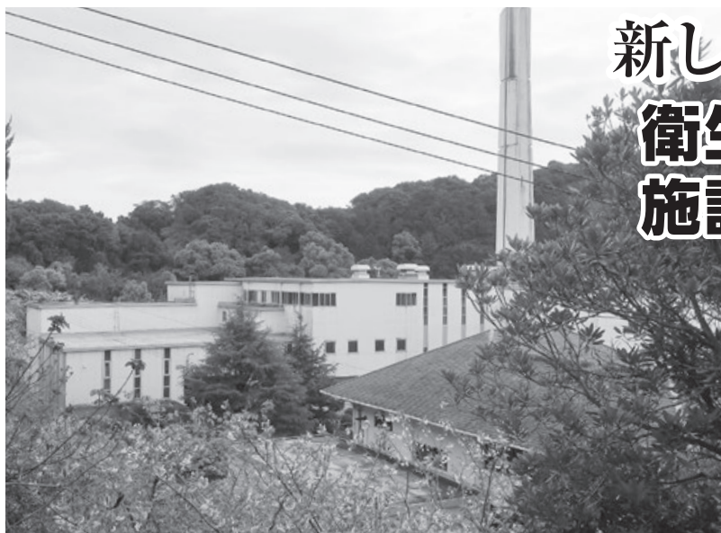
建て替え予定のごみ処理施設
