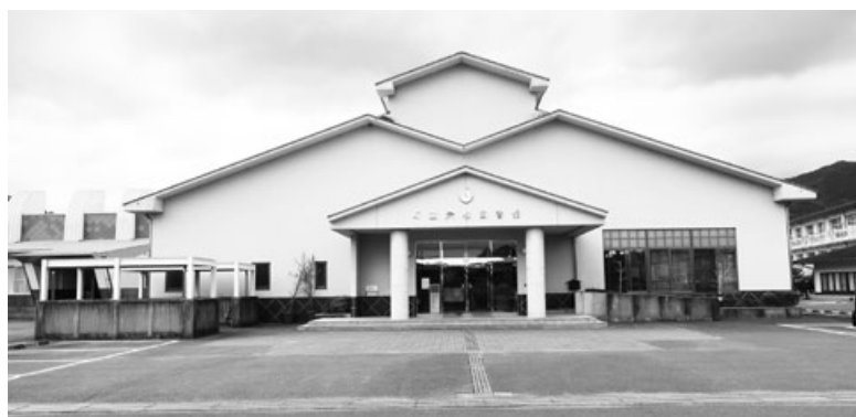
外壁、空調改修工事予定の宍喰図書館
