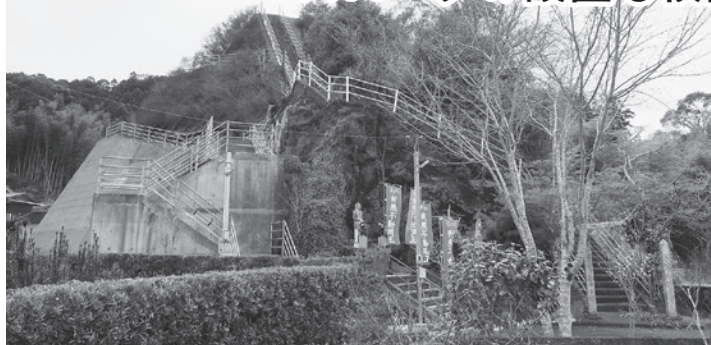
急階段がある津波避難場所（浅川・弁天神社）
