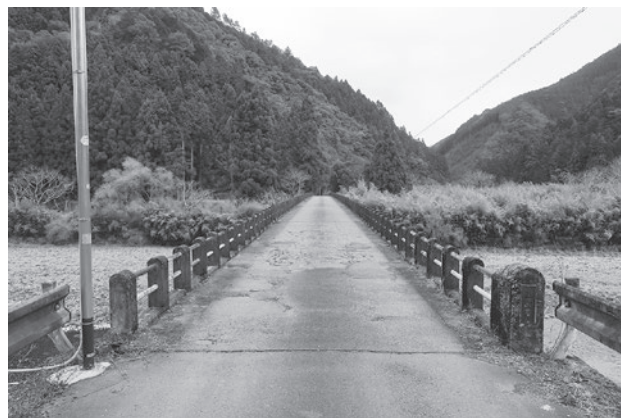
修繕詳細設計予定の玉笠橋
