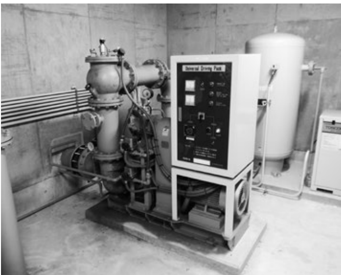
修繕する中角地区農業揚水ポンプ
