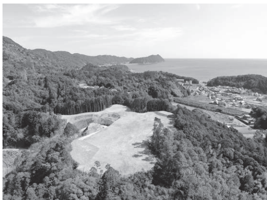
穴喰地区地域防災公園 令和8年3月の進捗状況
