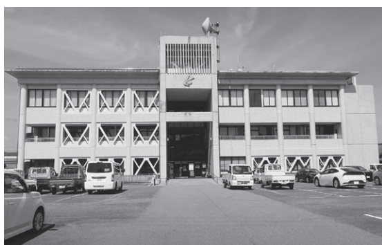
海陽町役場（海南庁舎）
